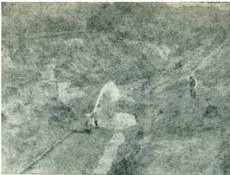
Explotación de metales preciosos de aluvión por el sistema de monitores en la región de Basarú, Departamento del Chocó. (Foto del geólogo Fernando Falla)
