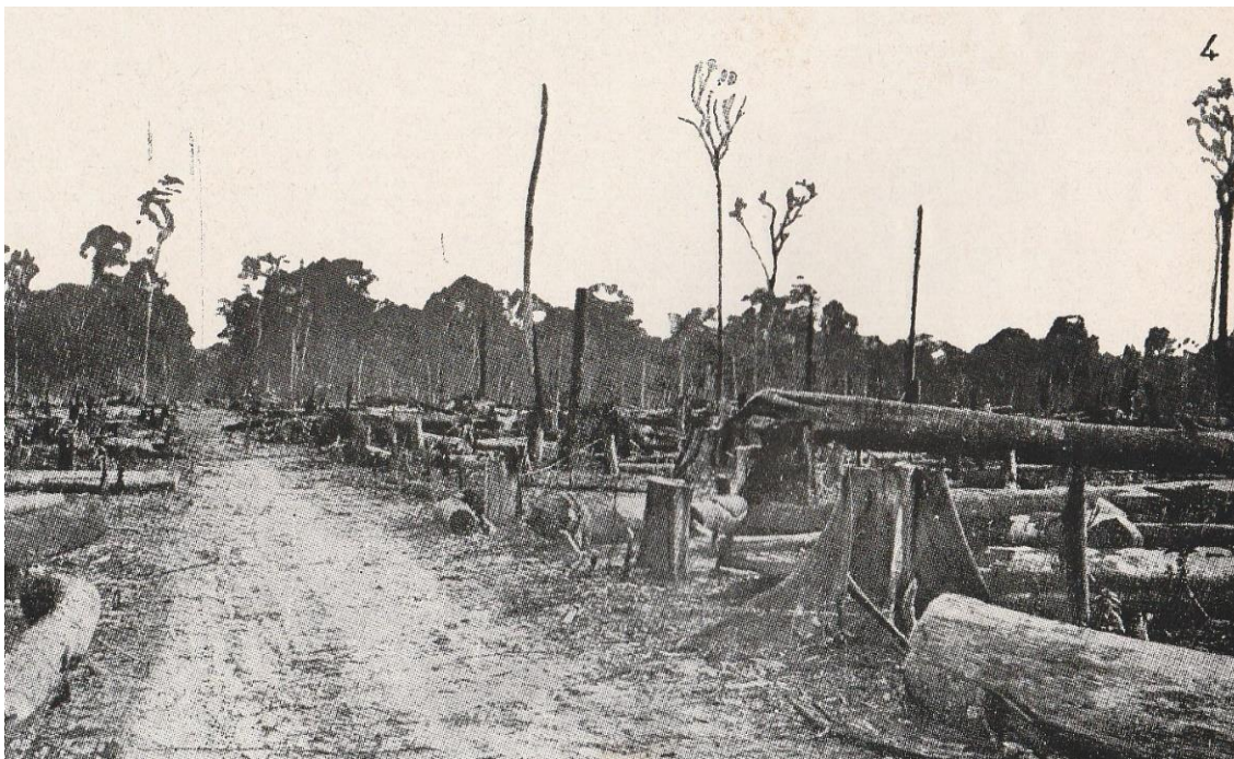
Otro aspecto de las rozas practicadas en la selva amazónica, que muestra la disposición natural de los árboles derribados, aprovechable para la colocación elevada de las carrileras. Decauville
