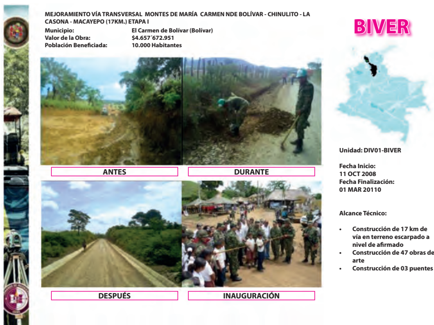
Figura 14. Trabajos de mejoramiento vial en El Carmen de Bolívar
